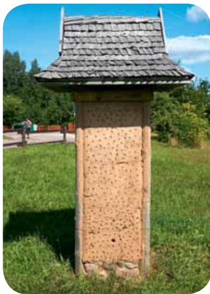
Fot. 20. Wygląd obecnie stosowanych konstrukcji z drewna i gliny
