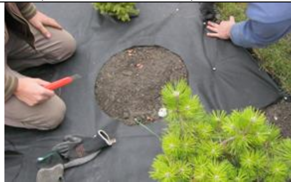
Fot. 5 Sadzenie roślin na włókninie.
