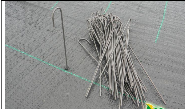
Fot.3 Sposób montowania włókniny.
