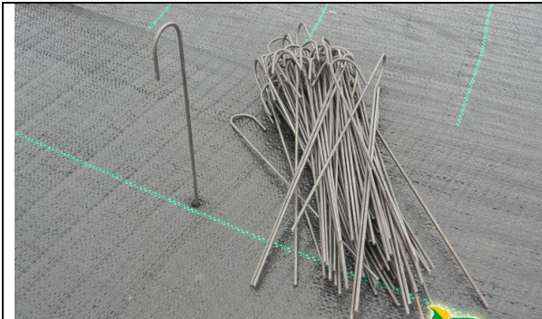
Fot.3 Sposób montowania włókniny.
