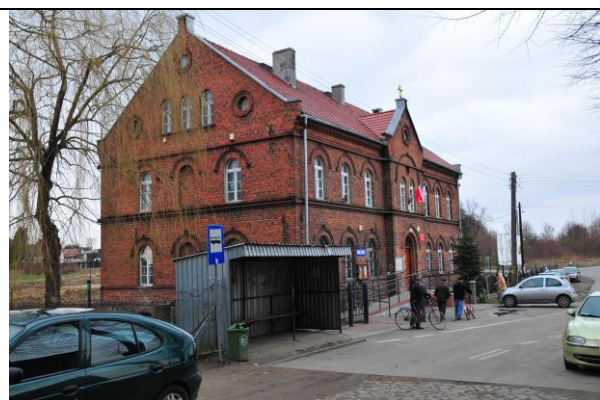
Fot. 2 Budynek szkoły.
