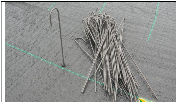
Fot.3 Sposób montowania włókniny.
